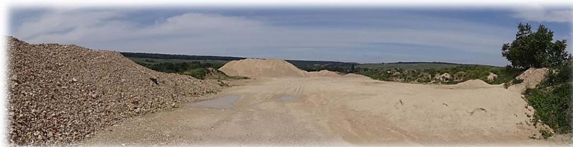
Entrée de la carrière depuis le chemin d'accès : plate-forme délimitée par des stocks et merlons plus ou moins végétalisés Courthiézy, mai 2020
